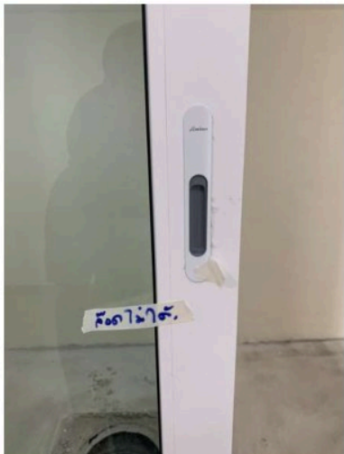
เก็บงาน Lock ไม่ได้ เก็บงานคอมเอียง สีข้างคอม เก็บงานสีขอบ
