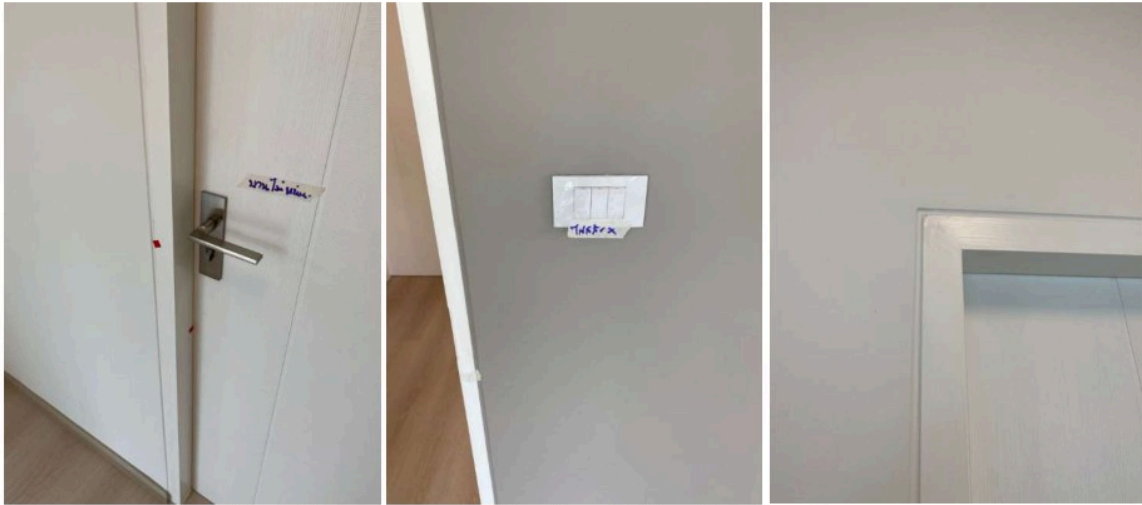
เก็บงานสีขอบวงกบ บานไม้แน่น เก็บงานไฟเปิดสลับ เก็บงานสีขอบวงกบ
