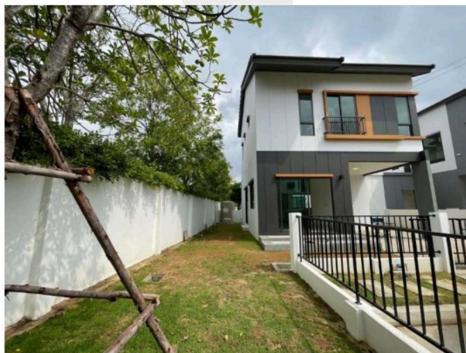
เก็บงานตัดแต่งกิ่งต้นไม้แนวผนังรั้วด้านบน และปิดฝาบ่อพัก ให้ครบทั้งหมด
