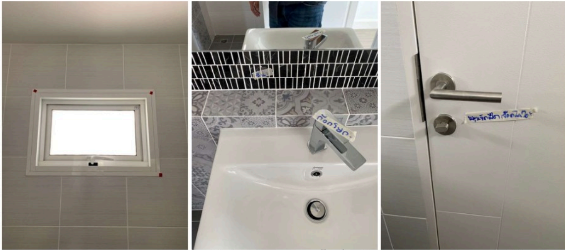
เก็บงานยาแนวขอบวงกบ เก็บงานก๊อกโยก เก็บงานกระเบื้องปูผนัง เก็บงานลูกบิด หมุนฝืด Lock ไม่ได้ ชั้นที่ 2 ห้องน้ำ
