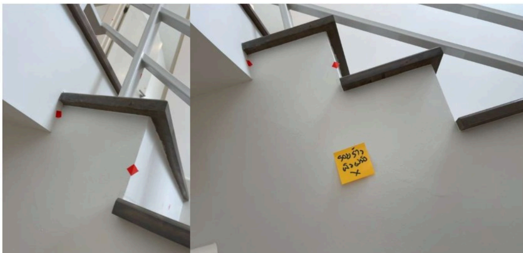
เก็บงาน งานสียาแนวแต่งขอบขั้นบันได - เก็บงานรอยราวจับผิวผนังไม่เรียบ
