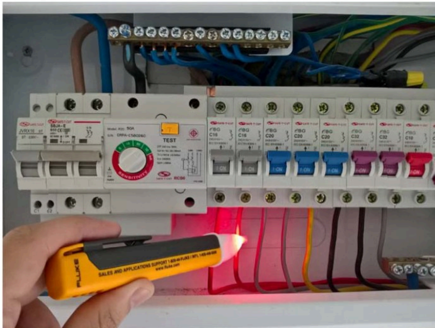
รูปที่ 102 ตรวจเช็คการติดตั้งสาย Line จาก Breaker ย่อย ถูกต้อง
