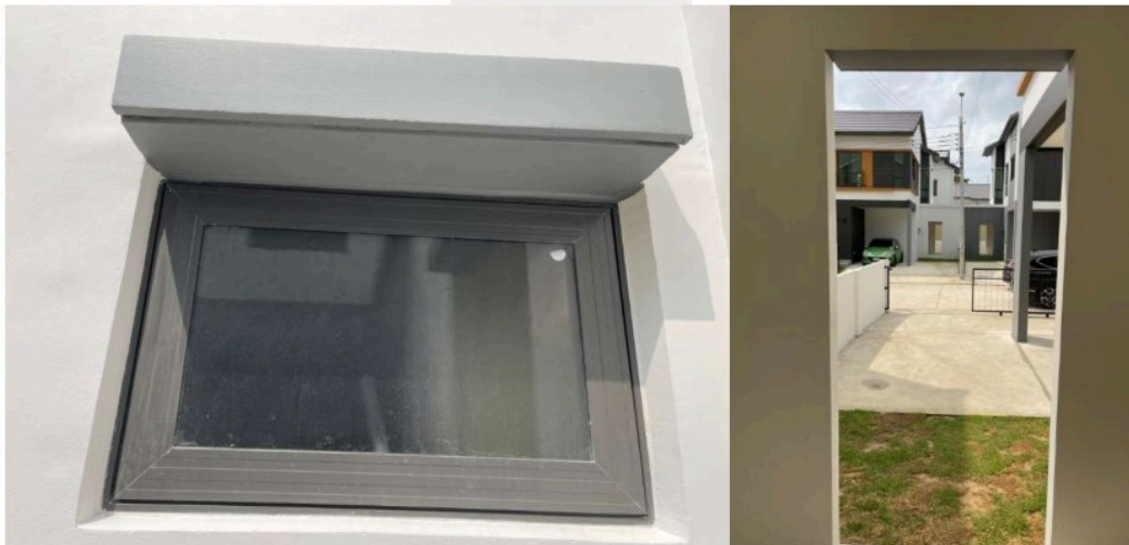
เก็บงาน สีแต่งมุมขอบวงกบและความสะอาด – เก็บงาน แต่งมุมวงกบประตูเบียร์ไม่ได้แนว
