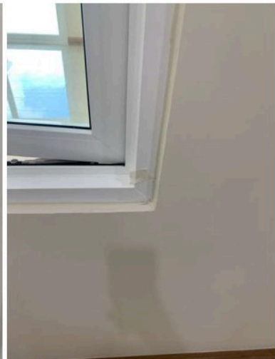
เก็บงาน Lock ไม่ได้ เก็บงานคอมเอียง สีข้างคอม เก็บงานสีขอบ
