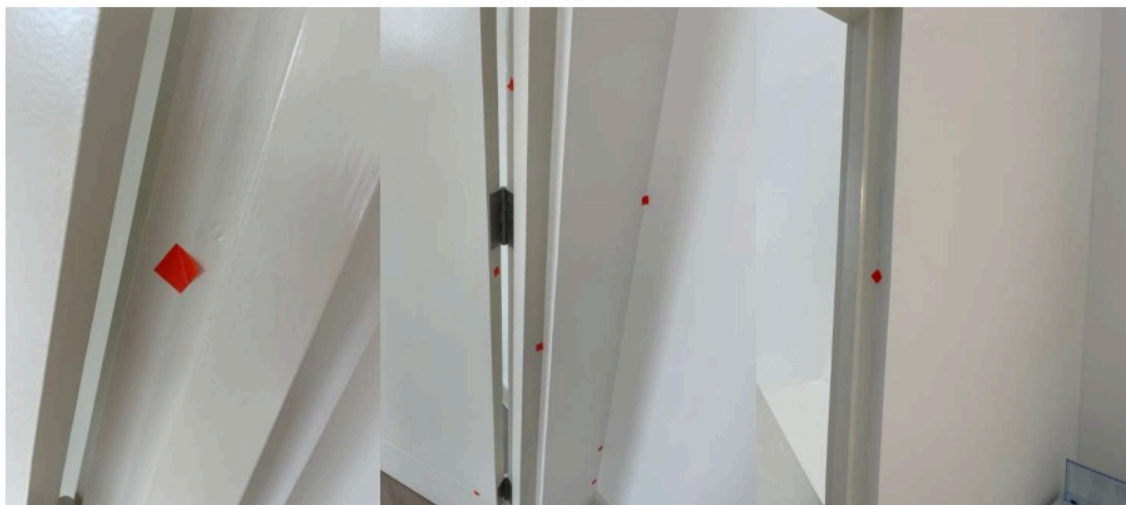
เก็บงานงานสีแต่งมุมผนังวงกบบิ่นเบี้ยวรอบบานวงกบ ขาแนวแต่งขอบบาน
