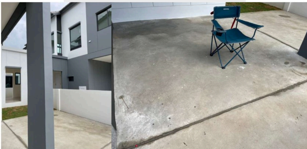
เก็บงาน แต่งมูมเสาบินเปี้ยวขรุขระ - เก็บงาน รอยร้าวร่องลานจอด และ ทำความสะอาดลานจอดสีและ
