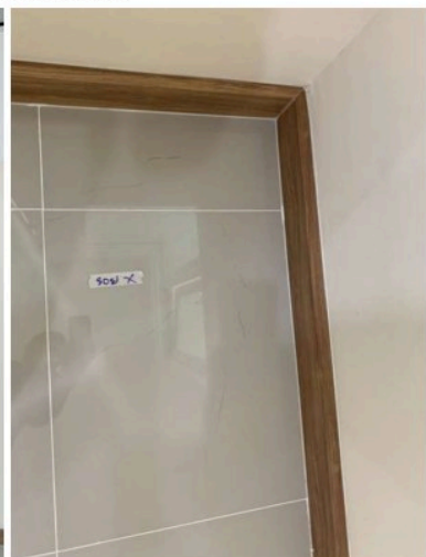
เก็บงาน Lock ไม่ได้ เก็บงานคอมเอียง สีข้างคอม เก็บงานสีขอบ
