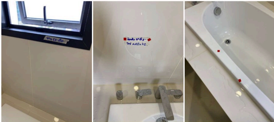
เก็บงานบานปิดขัดฝอย เก็บงานติดตั้งส้วมอ่างอาบน้ำ และ test ในการตรวจ 2 เก็บงานรอย
