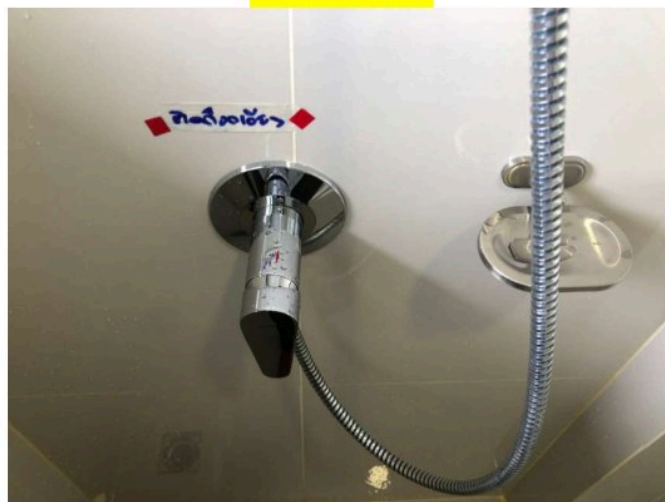
เก็บงาน ติดตั้งก๊อทดัดเอียง
