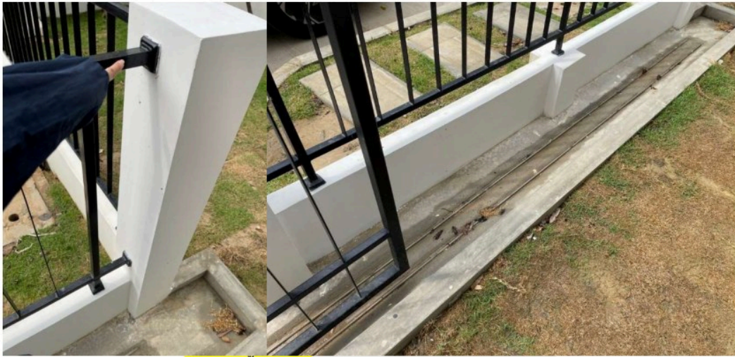
เก็บงาน รั้วไม่แน่น - เก็บงาน ทำความสะอาดรางประตูด
