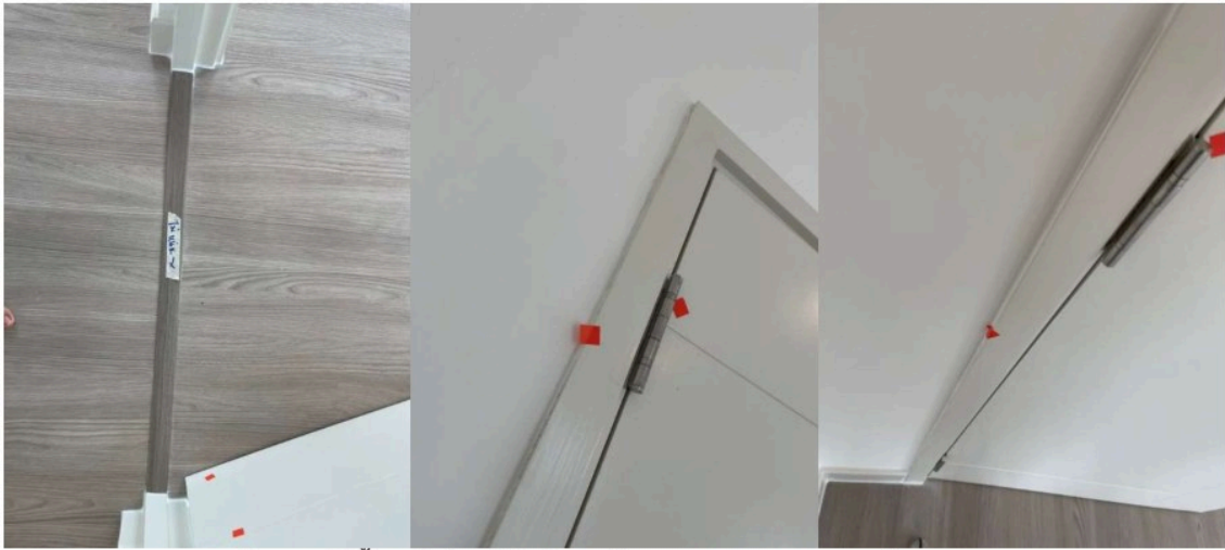
เก็บงานบัวพื้นกรณีประตูไม่แน่น – เก็บงาน ยานแนวขอบวงกบ สีขอบบาน
