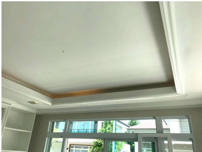
LED Strip light แสงไม่พอ และคนละสีกับดวงโคม
