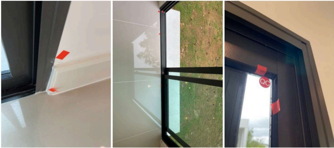
เก็บงาน สียาแนว- เก็บงาน ยางขอบบานมูมไม้ขีดกัน
