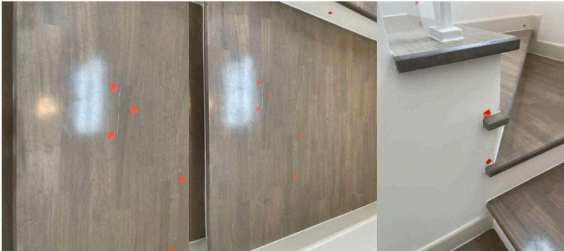
เก็บงาน พื้นบันไดราวจับ บัน - งานสียาแนวแต่งขอบขั้นบันได
