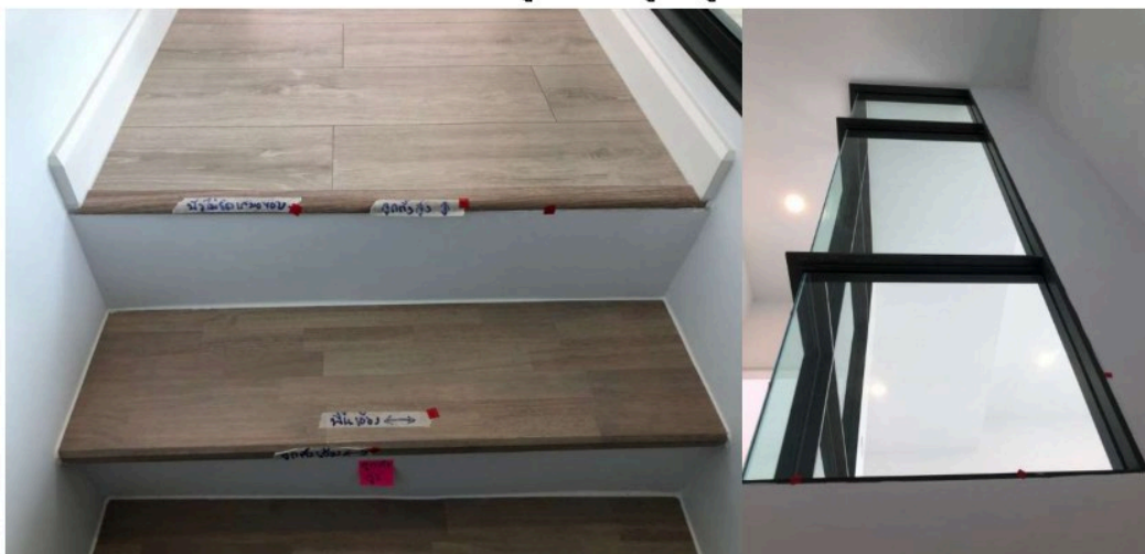
เก็บงาน บัวไม้ขีดเสมอขอบ ลูกตั้งสูง พื้นเอียง สีขอบบาน เฟรมเป็นรอย
