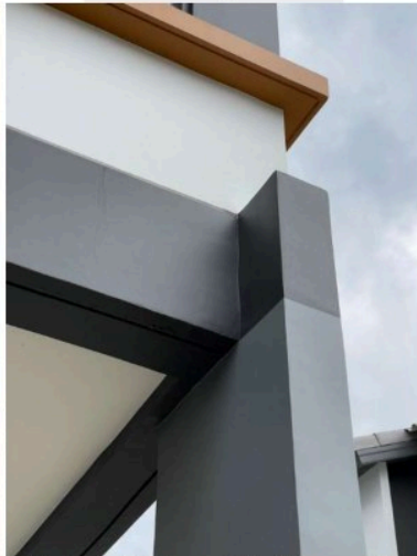
เก็บงานสีแต่งเส้นร่องผนังสีและผิวไม่เรียบ - เก็บงานสีผนังต่าง
