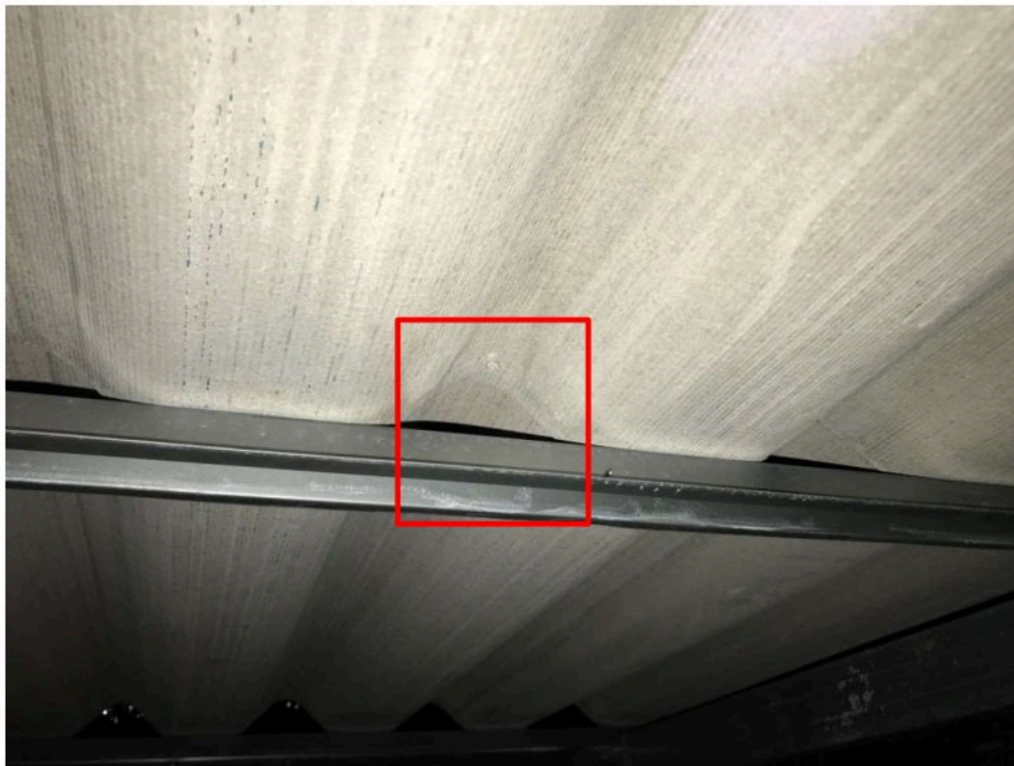
เก็บงานติดตั้ง Nuts หลังคา (รายการแก้ไข)
