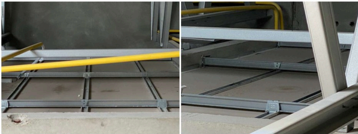
ตรวจสอบ แกะไขหลังคาน้ำรั่ว
