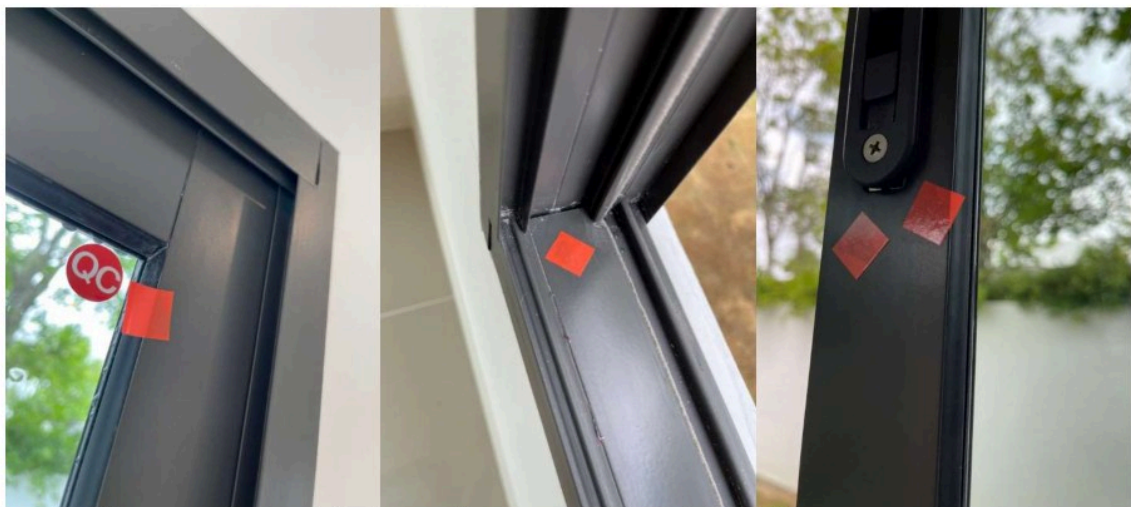
เก็บงาน ยางขอบบานมูมไม้ขีดกัน - เก็บงาน รอยต่อมูมเฟรมไม้ขีด - เก็บงาน ช่องว่างชุดลิ้นคบาน
