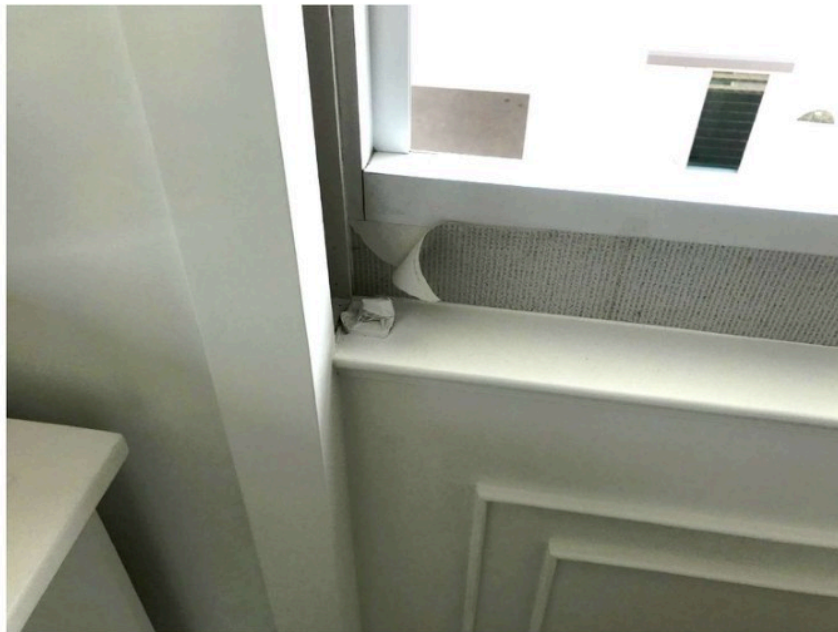
เก็บงาน Wallpaper ขาดเปลี่ยน
