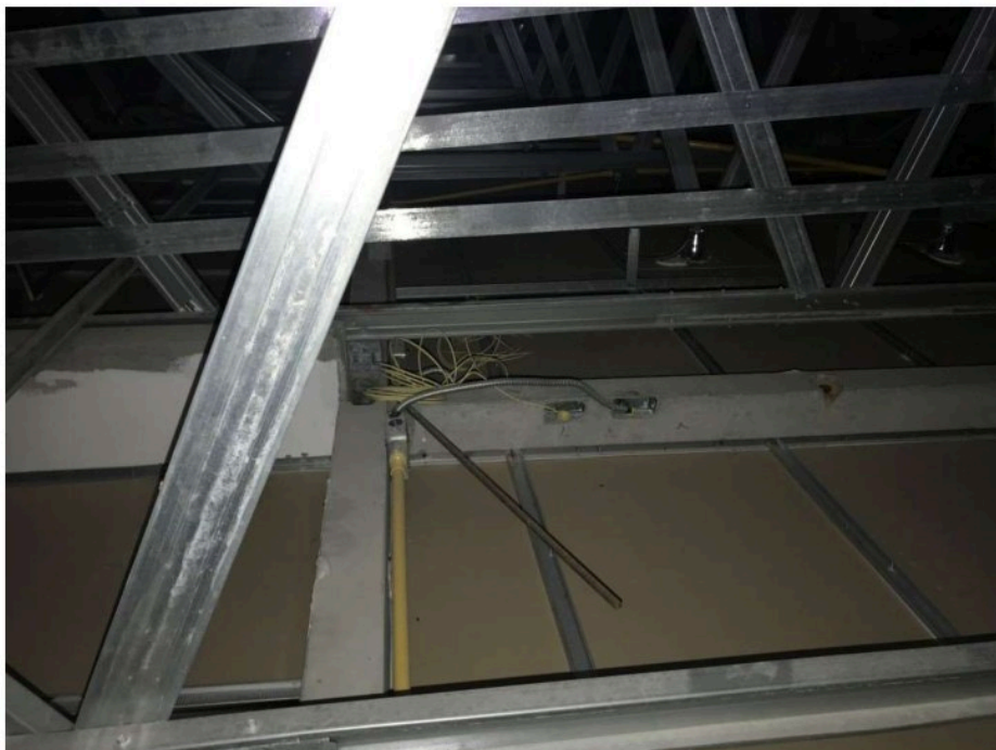
เก็บงานปิดฝา Box (รายการแก้ไข)
