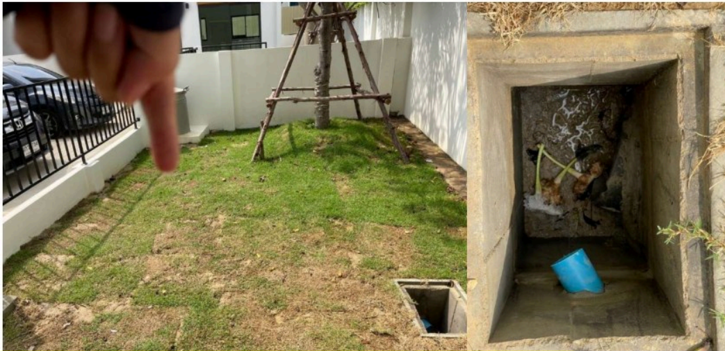
เก็บงาน เติมดินปรับพื้นให้แน่นเรียบเสมอ และ เปลี่ยนหน้าตายใหม่ทั้งหมด ดินทรุด เป็นหลุม - เก็บงานทำความสะอาดบ่อพัก
