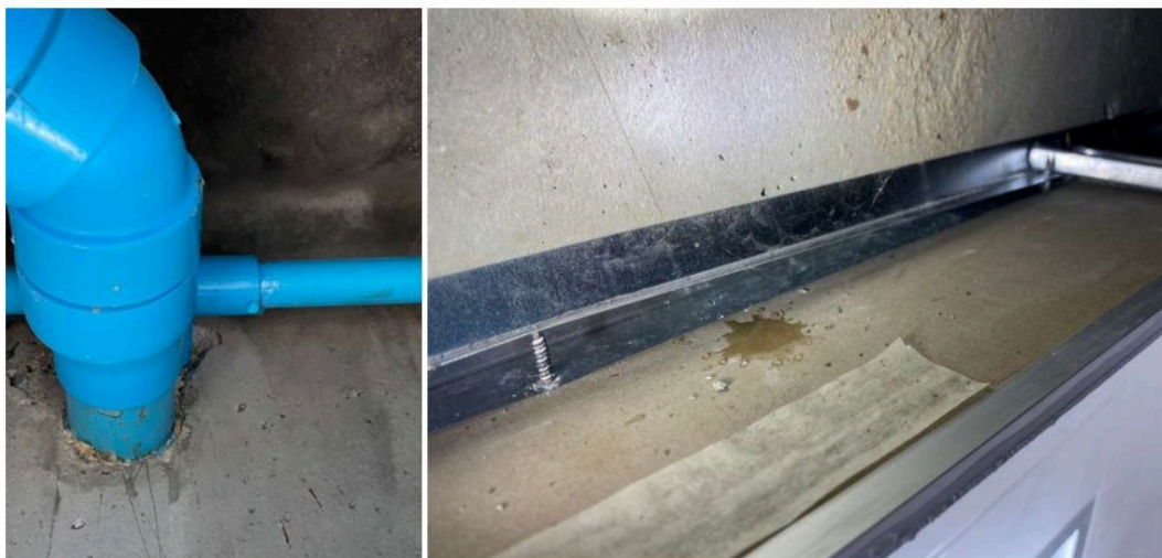
เก็บงานน้ำรั่วท่อ ฝ้า ห้องน้ำชั้น 1
