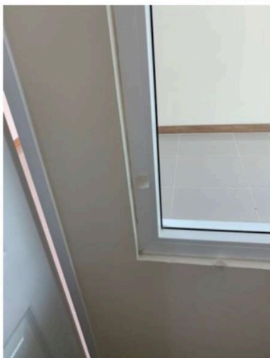
เก็บงาน Lock ไม่ได้ เก็บงานคอมเอียง สีข้างคอม เก็บงานสีขอบ
