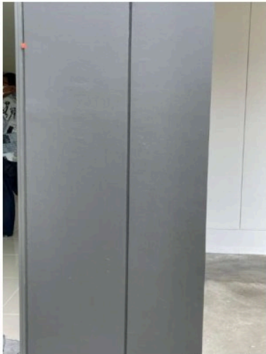
เก็บงานสีแต่งเส้นร่องผนังสีและผิวไม่เรียบ - เก็บงานสีผนังต่าง
