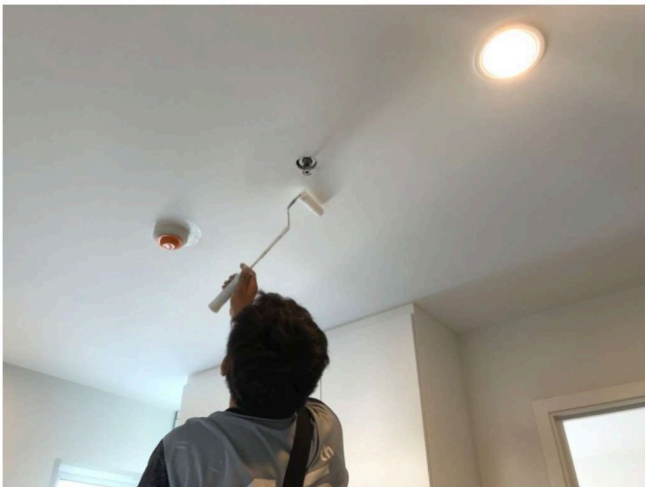
เก็บงานสีฝ้า รอบโคม (แก้ไขแล้ว)
