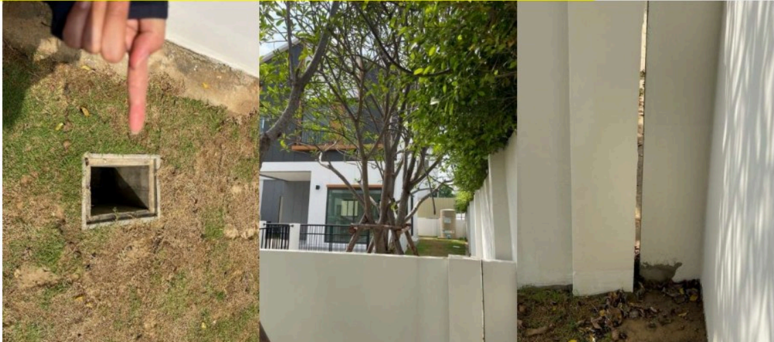
เก็บงาน ติดบ่อเอียง - เก็บงาน สีนัง
